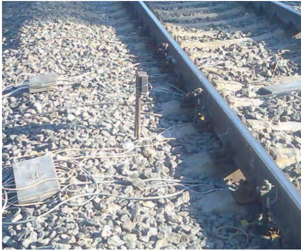
Рис. 7. Послідовність трьох перерізів рейки, обладнаних датчиками
