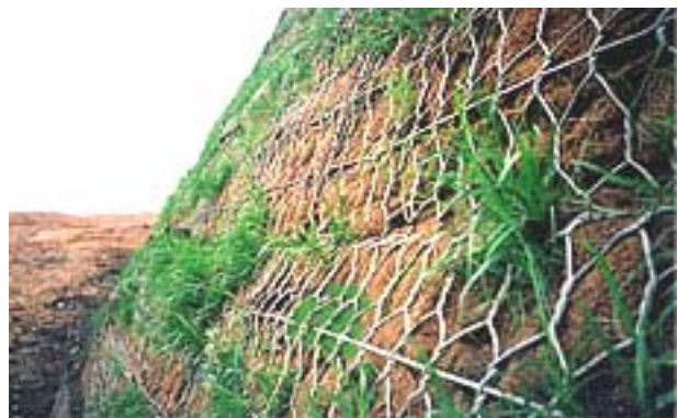
Рис. 6. Зовнішній вигляд улаштованої системи «Зелений Террамеш»
