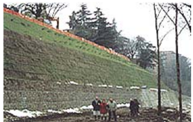
Рис. 7. Укріплені системою «Зелений Террамеш» відкоси
