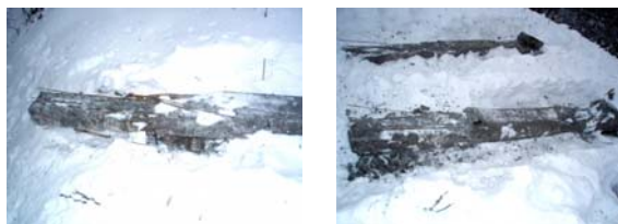
Рис. 3. Шпали 2005 року виготовлення, вилучені з експлуатації на Південно-західній залізниці
