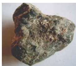
Рис. 6. Зразок щебеню в зруйнованому бетоні
