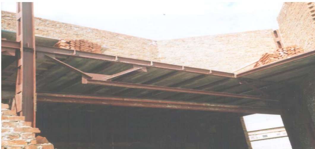
Рис. 8. Балко-ферма перекриття
