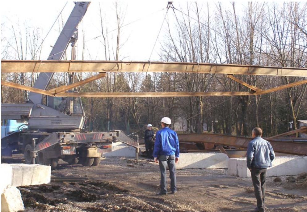
Рис. 4. Монтаж малоелементної шпренгельної ферми прольотом L=12 м. Санаторій «Женева», м. Трускавець, 2004 р.
