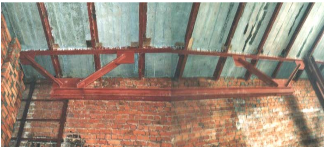
Рис. 9. Балко-ферми перекриття в складі монолітного залізобетонного перекриття
