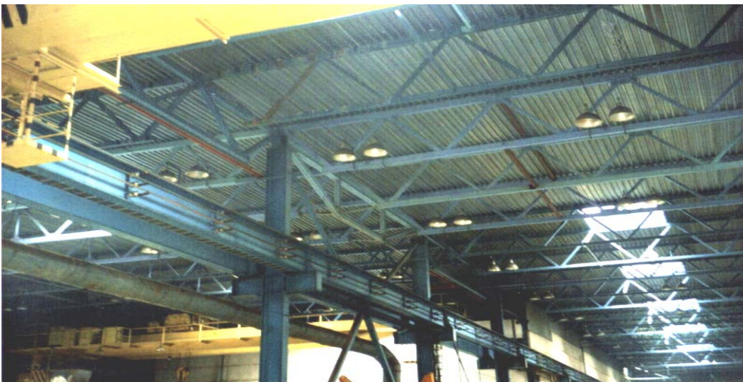
Рис. 7. Підкрівлена балко-ферма L=12 м. Завод експериментальних механічних випробувань, м. Львів, 2004 р.
