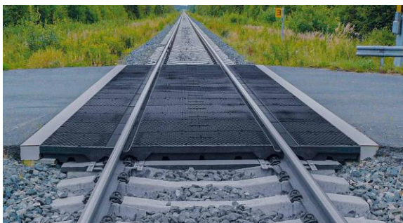
Рис. 2. Система гумових плит на переїзді
