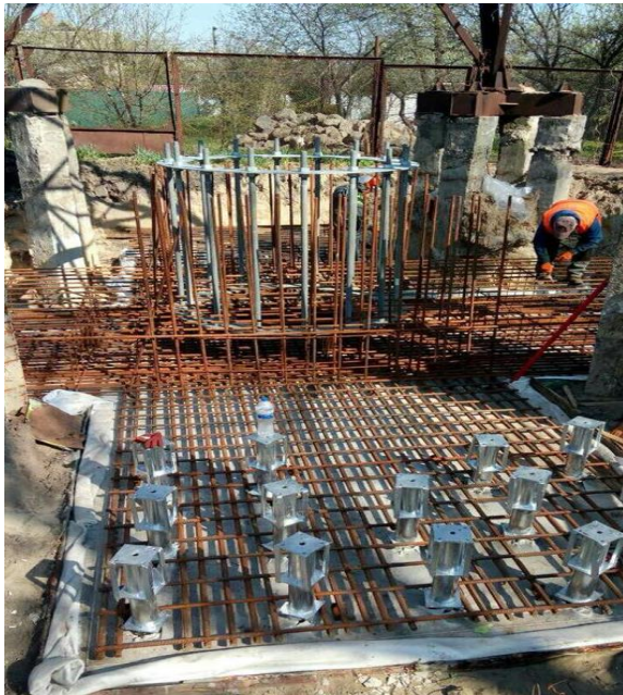
Рис. 12. Розміщення паль відносно нижньої сітки армокаркасу
