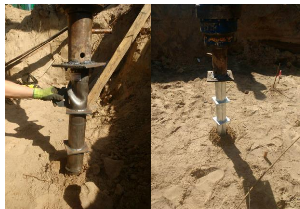
Рис. 10. Втрата стійкості оголовка палі під час занурення
