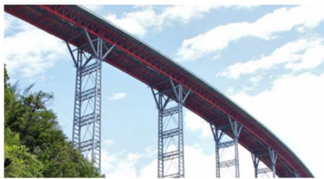
в) міст Ганхайзі (Ganhaizi Bridge)
