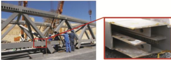
Рис. 7. Реальне застосування посилення ребрами конструкції мосту
