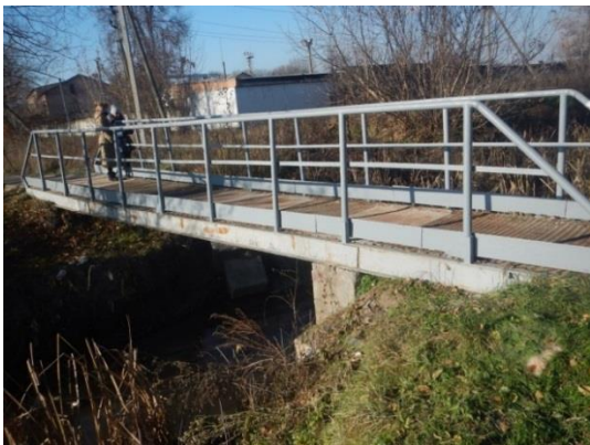
Рис. 2. Загальний вигляд пішохідного мосту через р. Верхня Хортиця, м. Запоріжжя
