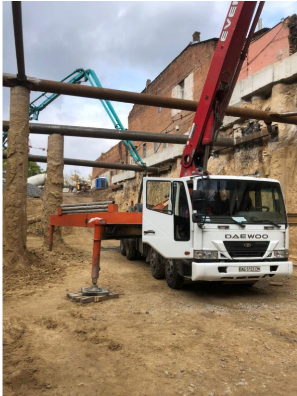
Рис. 8. Подача бетонної суміші бетононасосом № 1 до приймального бункера бетононасоса № 2 в умовах обмеженості будівельного майданчика.
