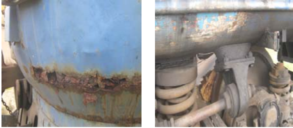
Рис. 6–7. Види корозійних пошкоджень несучих конструкцій, обшивки кузова та місць закріплення вузла передачі тягового зусилля
