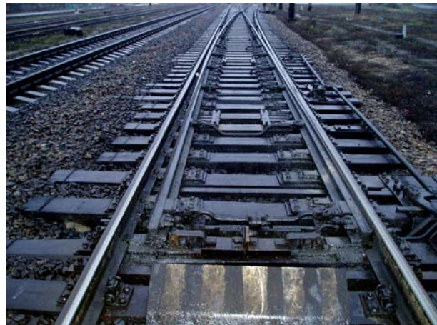
Рис. 1. Общий вид стрелочного перевода Дн 060.00.000, уложенного на ст. Вольнянск
