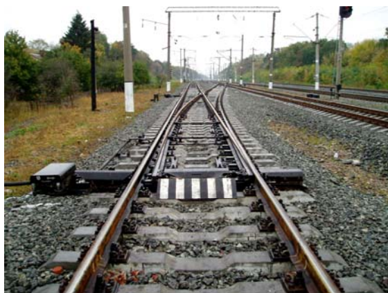
Рис. 2. Общий вид стрелочного перевода Дн 300.00.000, уложенного на ст. Холимоново
