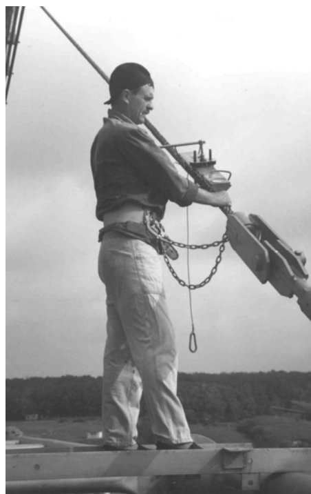
Рис. 10. Измерение усилий в наклонных подвесках с помощью накладных динамометров
