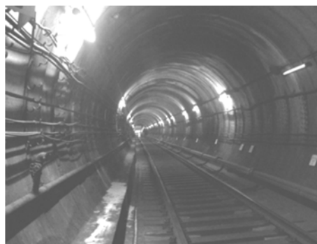
Рис. 1. Общий вид участка перегонного тоннеля
