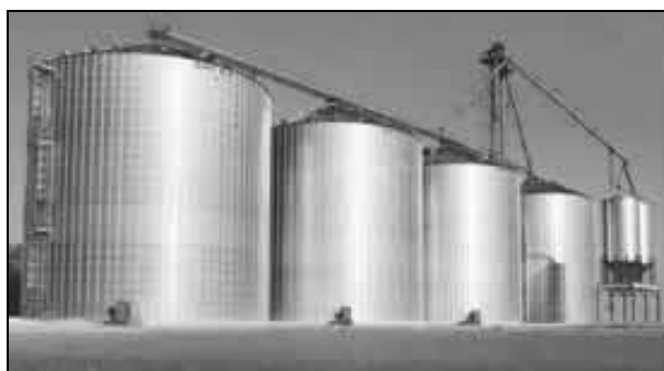
Рис. 2. Сталеві силосні ємності із гофрованих листів
