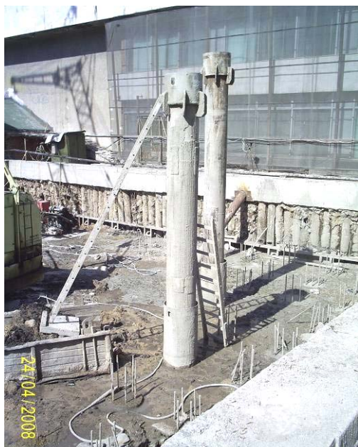
Рис. 23. Погружение внутренней трубы с заглушенным нижним торцом в обсадной трубе
