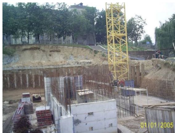
Рис. 12. Ограждение котлована для здания ОАО «Приорбанк» по пр. Победителей в г. Минске:
