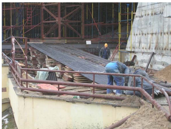
Рис. 11. Сборка анкерных тяг для постоянных анкеров на стенде в условиях объекта
