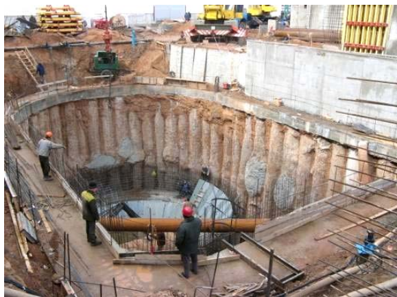
Рис. 15. Ограждение котлована из буронабивных свай диаметром 1,0 м на БАЗ в г. Жлобине
