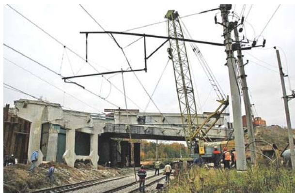
Рис. 9. Разборка путепровода через железнодорожные пути на 167 км автомобильной дороги М-3 «Украина»
