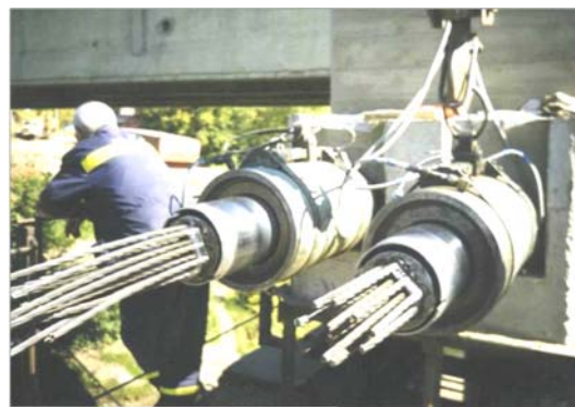
Рис. 3. Натяжение арматурных пучков
