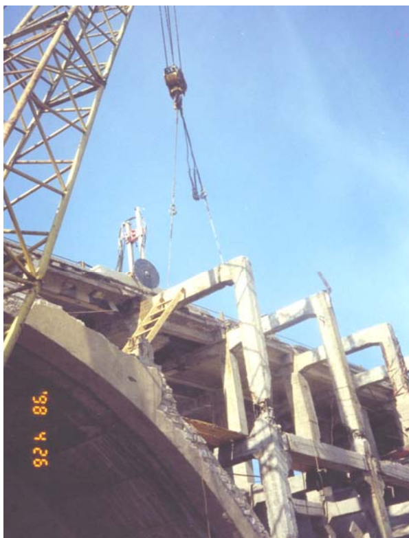
Рис. 8. Разборка надарочного пролетного строения на мосту через р. Волгу
