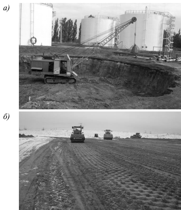
Рис. 1. Технологія зведення дослідних ґрунтових подушок: а – під резервуар ємністю 3000 м 3 ; б – під споруди електрометалургійного заводу
